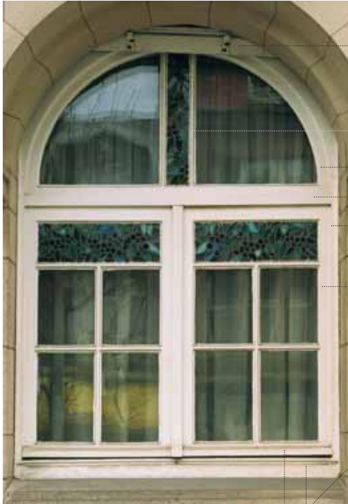
Châssis à double ouvrant et imposte fixe
