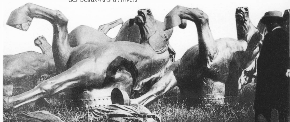
Les chevaux du quadrigé sont entreposés sur le terrain d'un manège, faute de place dans l'usine. La KARLSRUHER BAUORNAMENTER FABRIK UND KUPFERTREIBANSTALT PETER HUCKSCHLAG s'est chargée de la fonte en bronze.
