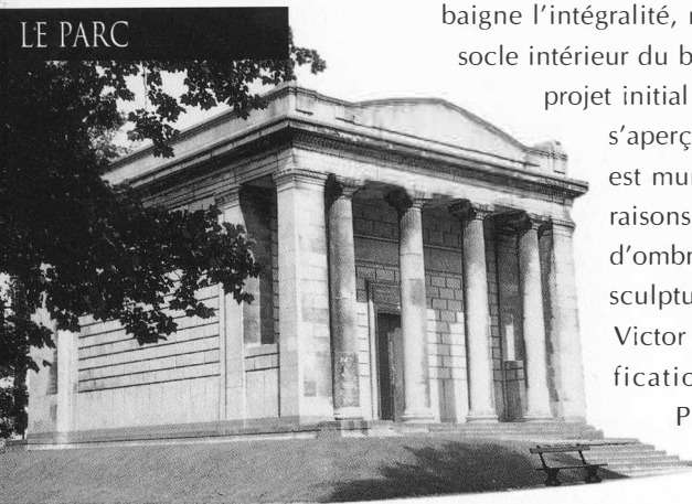
Pavillon des Passions humaines, premier monument construit par V. Horta en 1889. La transformation du langage classique du temple annonce déjà les prémices de l'Art Nouveau.
