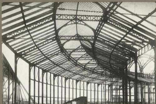
Construction de la galerie courbe derrière la colonnade nord pour l'Exposition de 1880.
