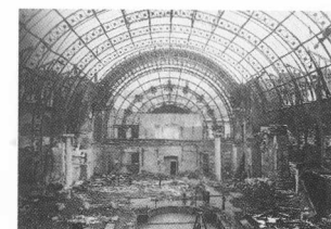
Le 19 janvier 1946, le Pavillon de l'Antiquité prend feu suite à un court-circuit. Un mois plus tard, la charpente effondrée est déblayée. Heureusement, ces gravats ont protégé les mosaïques d'Apamée qui n'ont pas trop souffert du sinistre.
