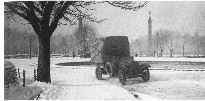
Sous la neige. Occupation allemande pendant la Première Guerre mondiale. Les colonnes de Quenast de 1880 sont visibles à l'arrière-plan.
