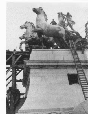
Montage du quadrigé quelque temps avant l'inauguration en mai 1905. Pendant cinq mois, quatre ouvriers allemands assemblent les parties éparses du monument fabriqué à Karlsruhe et battent le cuivre pour les couvrir. Hauteur des chevaux : 6 mètres.
