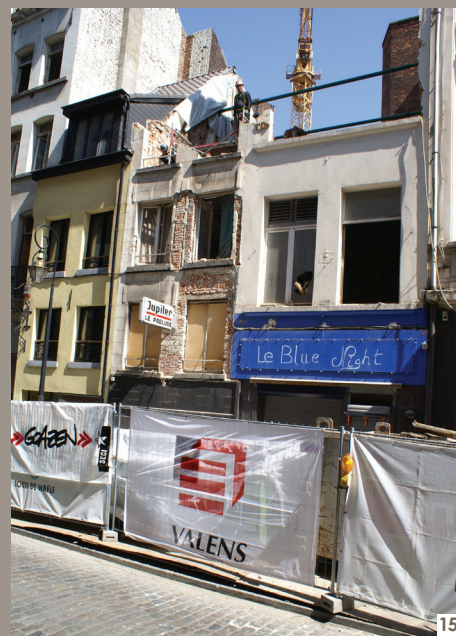
15 Rue des Pierres n o 32 et n os 34-36 en démolition. © MRBC-DMS
