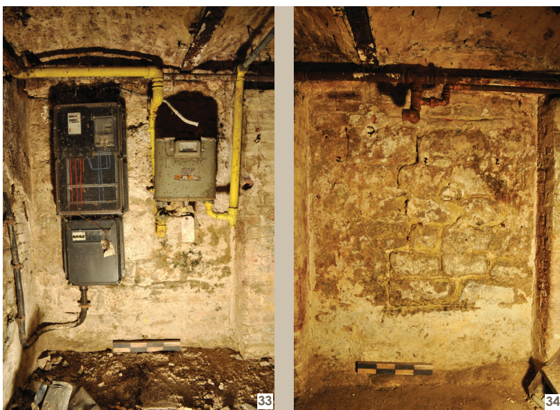
33-34 Dans les caves de la maison n o 34, le mur mitoyen du n o 32, on observe sur quelques mètres, de part et d'autre d'un petit pilastre, une maçonnerie de pierre faite de gros blocs et liée au mortier beige-jaune ( UC 3489 ). L'autre parement de ce mur est partiellement visible depuis les caves de la maison n o 32.
