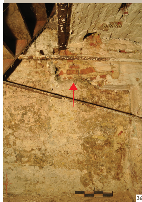
35 La baie dégagée au niveau du deuxième étage de la maison n° 34 (UC 3465), nous renseigne sur le type de percement de la maison primitive. Il s'agit de baies aux encadrements de pierre blanche (moulure à angle droit) avec linteau droit sous un arc de décharge unique. Les baies ne semblent pas équipées de meneaux et traverses. Elles ont, à la période néoclassique été transformées : diminution de la largeur, pose d'un appui saillant en pierre bleue et d'un garde-corps. © MRBC-DMS
