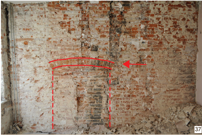
37 Au niveau du deuxième étage, la maçonnerie contient un arc (UC 3493), vestige d'une circulation de chantier ? La hauteur de l'arc dans la pièce par rapport au plancher n'autorise pas à penser à l'identifier comme une porte permettant de passer d'une pièce à l'autre entre les maisons n os 32 et 34. Les coutures sous les arcs peuvent-elles être le témoin d'un ancien passage temporaire ?
